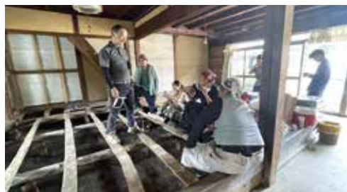
改修過程で実施した古材保存・解体体験の様子。大正初期の建築物の構造や改修の履歴、未来について、解体しながら実感したことを共有した。
