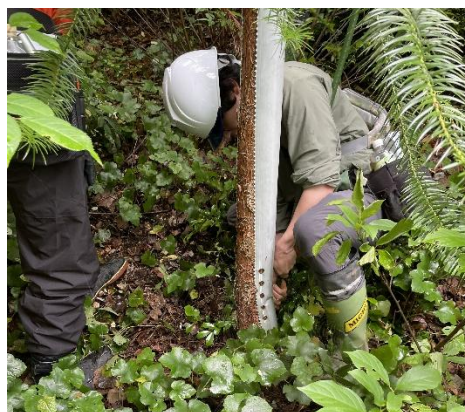
撤去作業中の様子
