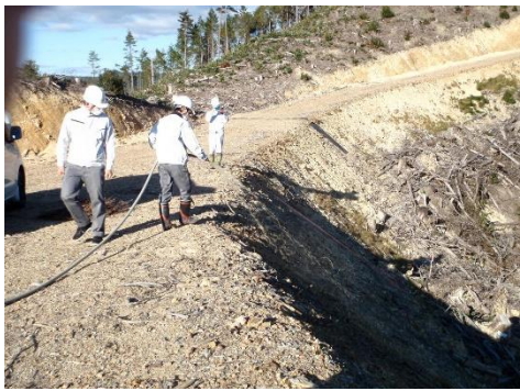
令和3年10月29日施工(南向き盛土法面)
