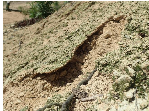
令和5年8月31日(南向き切土法面)
