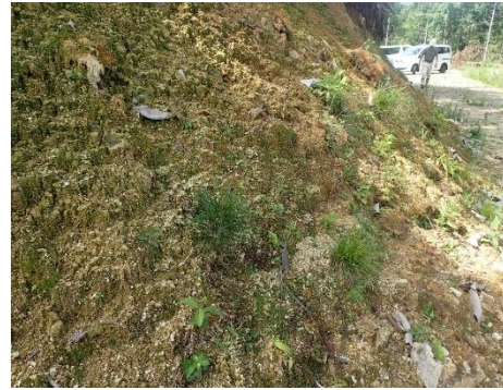
令和5年8月31日(北向き切土法面)
