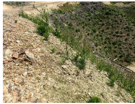
令和5年8月31日(南向き盛土法面)
