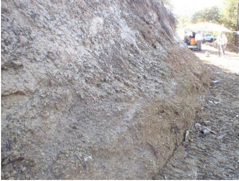
令和3年10月29日施工(北向き切土法面)
