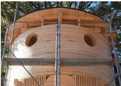
曲面壁の下地は根気のいる大工仕事
