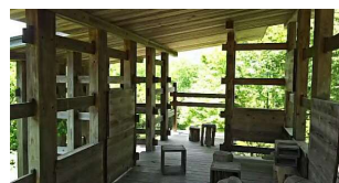
半屋外軒下曝露(外壁を想定)
