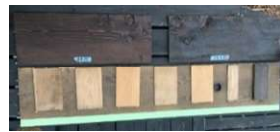
屋外平置き曝露の様子(デッキを想定)
