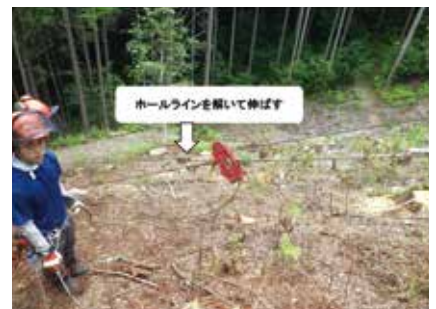
写真-8 クランパー(下側)を外しHALを解く
