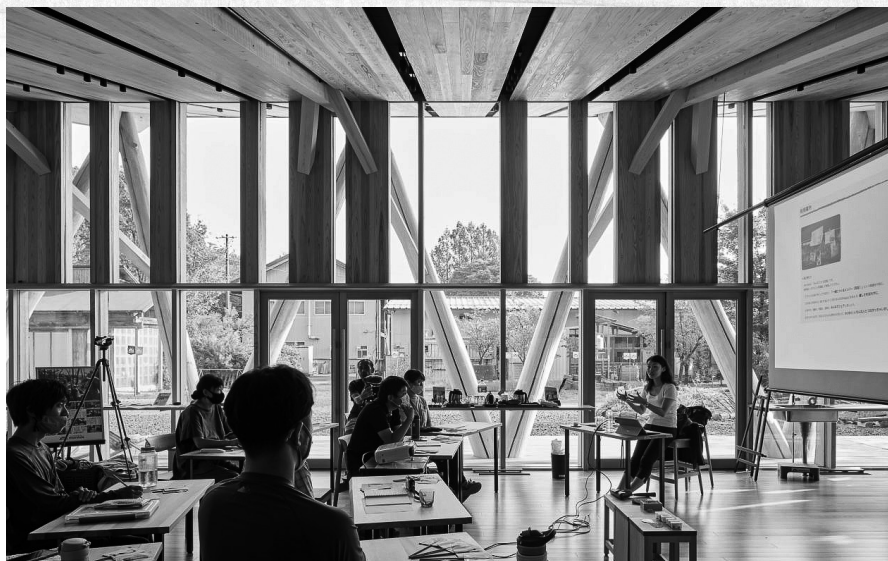
耐震性能を高め、屋外に開かれた開放的な室内空間。外部に丸太のトラス架構が見える。
