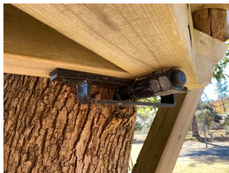
GLボルト工法
