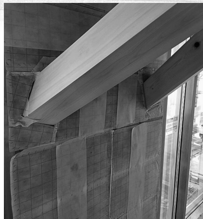
方杖が貫通する複雑な外壁
