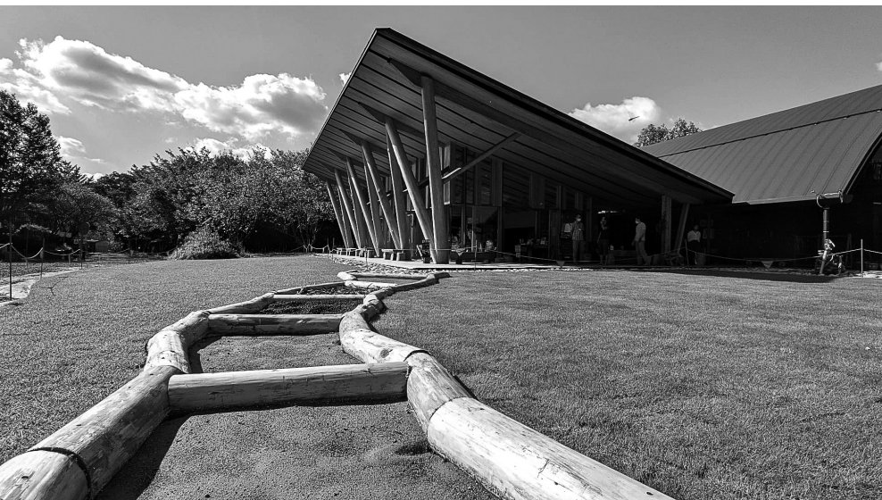
morinosを南東から見る。手前はいろいろな素材が敷かれた「はだしの広場」
