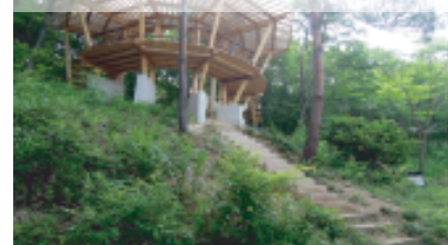
演習林内の休憩小屋 規格材である地場の四寸角材のみの架構
