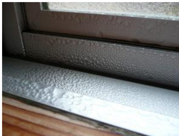
アルミサッシ、1枚ガラスの結露
