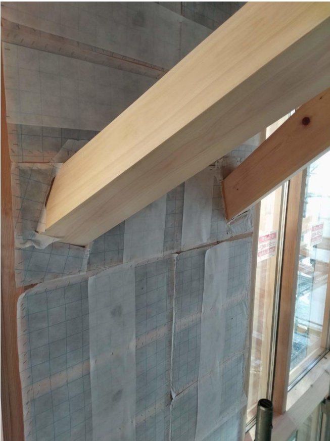
外壁の 150mm 厚のセルロースファイバー
