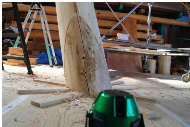
【クレーンで丸太を釣り、設計通りの角度に傾け、レーザーで中心を出す墨付け作業】
