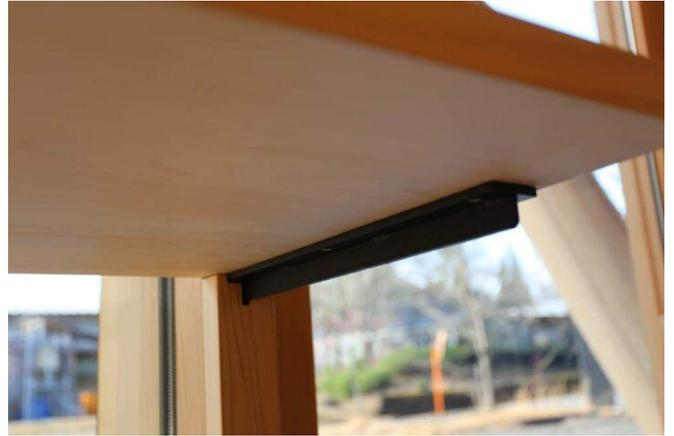
カウンターの下に脚があると使いにくいので、スチールの持ち送りで支えています。スチールが目立たないようにすると、カウンターが浮いて見えて、空間が軽やかになるので、スチールの縦柵は上手に隠しています。
