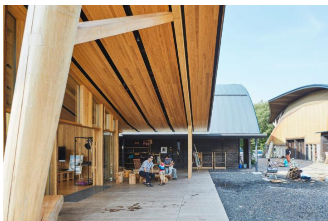
morinos 竣工写真 建物東面エントランスポーチ(撮影:千葉颯弥)
