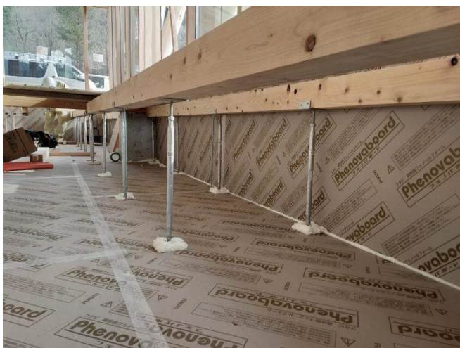
フェノールフォーム施工中の写真。端部や部材取り合いは発泡ウレタンで補完。目地はテープで目張りして湿気の流入を防止。
