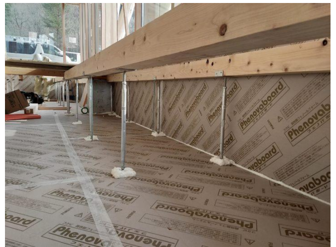
床下の基礎断熱はフェノールフォームの一種、フェノバード
