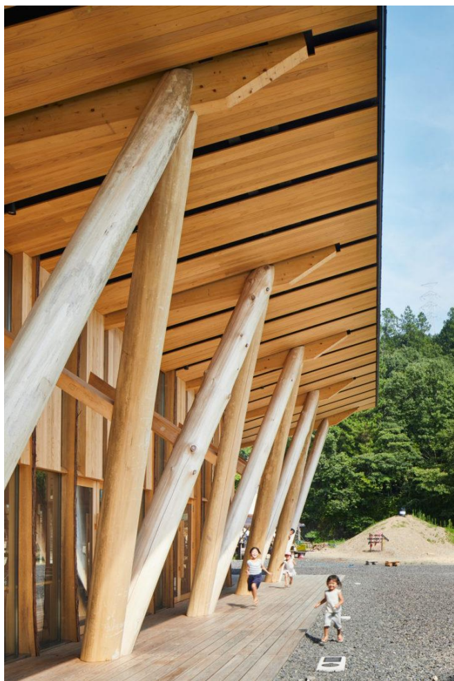
morinos 竣工写真 建物南面(撮影:千葉颯弥)
