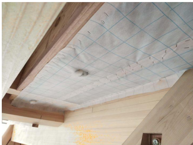
屋根に、二重に吹き込まれたセルロースファイバー
