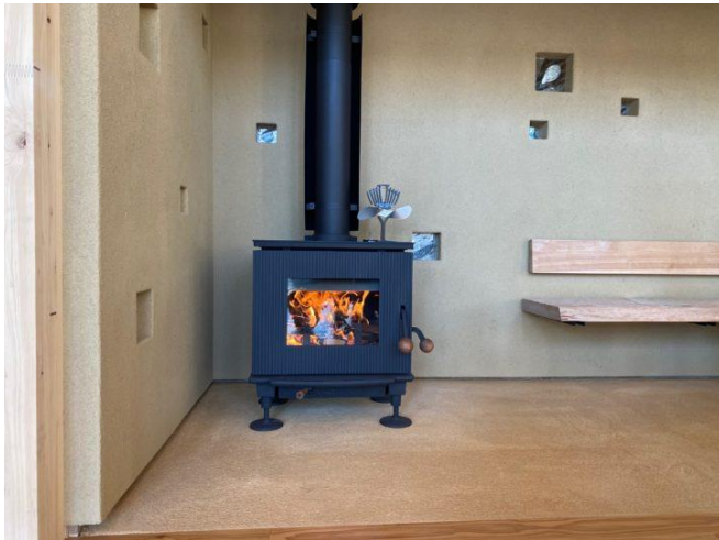
距離感で暖かさが変化する放射暖房設備：薪ストーブ
