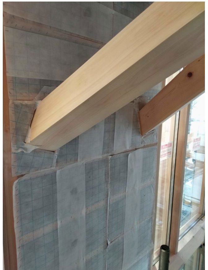
外壁の 150mm 厚のセルロースファイバー
