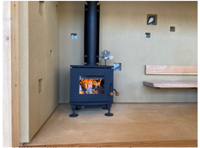
二次燃焼+触媒を利用した薪ストーブ
