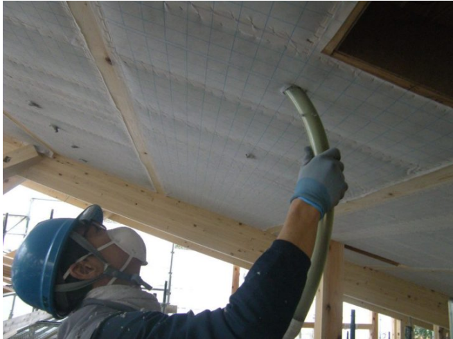
morinos の屋根にセルロースを吹き込んでいる様子
