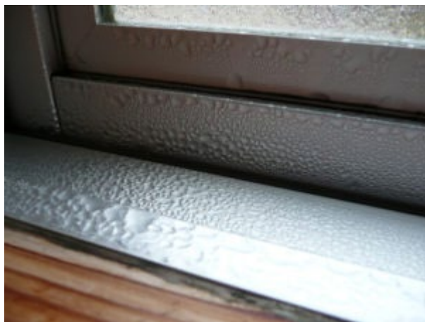
アルミサッシ、1枚ガラスの結露
