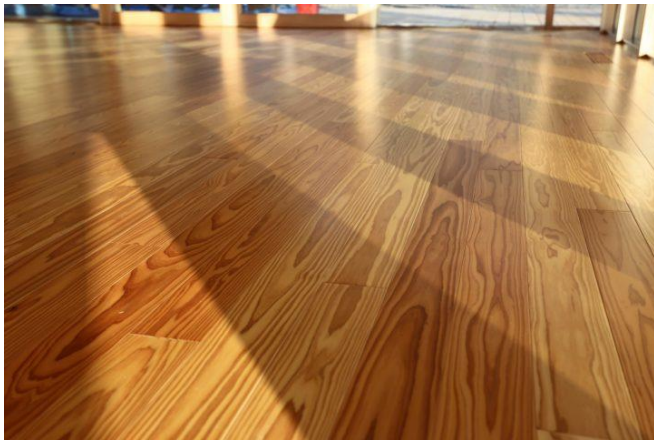
圧密フローリングに、UV セラミックコーティング
