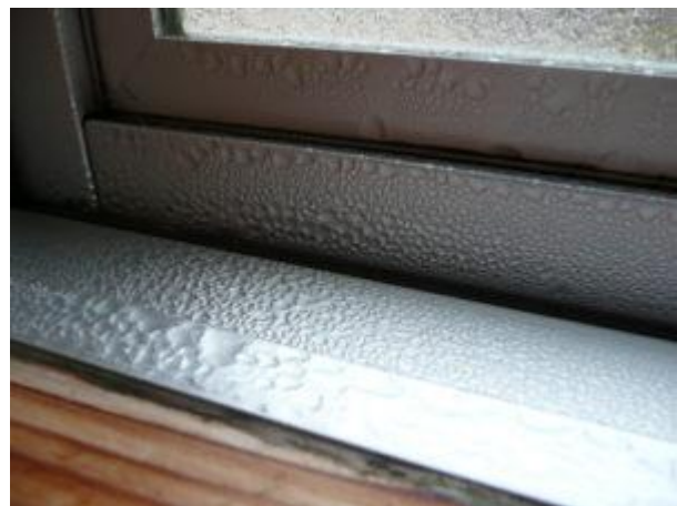
アルミサッシ、1枚ガラスの結露
