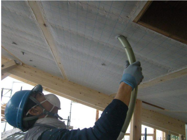
morinos の屋根にセルローズを吹き込んでいる様子
