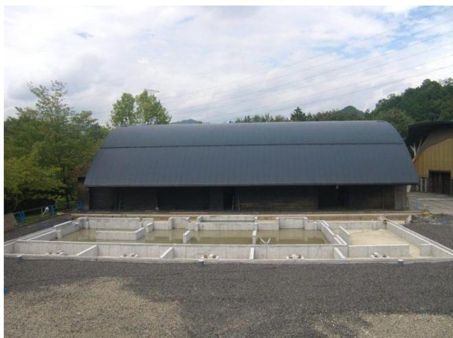
基礎を構成する材料の品質について建設中にいろいろな検査をして、確認しています。配筋用の鉄筋については抜き取り検査により強度を検査しています。
