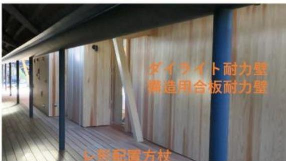
この morinos は構造システムを"WOODS"(Wooden Object Oriented Design Structure、木材のオブジェクト指向型設計)と名付けた構造体です。各構造要素を組み合わせた効率の良い構造計画が実現しています。主要軸組(構造架構)は自重や積雪荷重などの鉛直荷重だけを支持するのではなく、地震力や風圧力などの水平力も負担できる構造架構を兼ねている部材があります。ここでいう構造架構とは、架構の接合部の回転性能に配慮し、ラーメン的構造性能を付加した架構のことです。北側壁面部分や収納部分の界壁等には面材耐力壁を配置し、水平構面は CLT 面材を配置しています。
