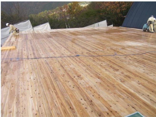
この A パネによる CLT 面材水平構面は、2015 年(平成 27 年)に森林文化アカデミー・木材開放試験室で実大水平構面試験を実施した後、指定性能評価機関ハウスプラスにて技術評定を取得しています。
