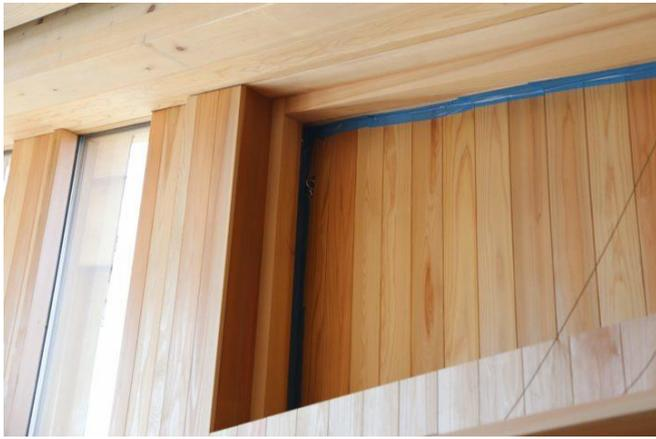
結果は、C 値は  $1.71 \text{ c m}^3/\text{m}^2$ 。αA は  $372 \text{ c m}^3$ 。4枚の建具で、 $349 \text{ c m}^3$  の隙間がありました。特に大きかったのが収納庫の木製建具。  $200 \text{ c m}^3$  近くあります。
