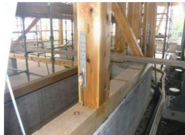
一般部分の接合部には、市販の補強金物を使用しています。それほど引張力が大きくない接合部には一般的な座金-ボルト接合なども使用しています。
