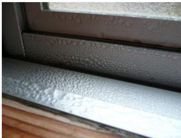
アルミサッシ、1枚ガラスの結露
