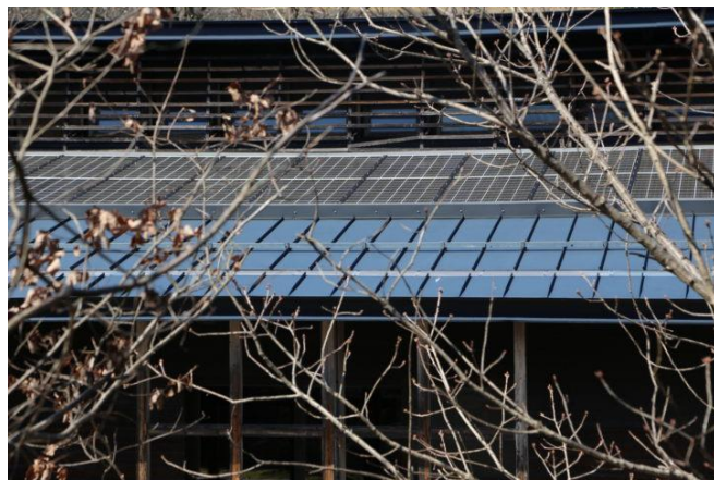
アカデミー本校舎の太陽光発電。10kW を5か所の屋根に設置し計 50kW の容量。
