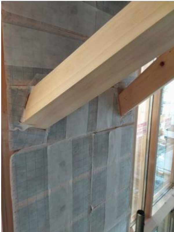
丸太から斜めに伸びる方づえ廻りの施工
