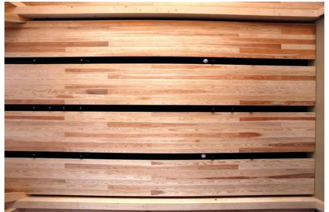
他のスリットは 150mm 巾として、内部に照明や火災報知器、防犯センサー(これは黒く塗れなかった)など機能的な設備が仕込まれています。スリット内の色は、単純な黒ではなく、照明器具の黒に合わせて調色して目立たないようにそろえています。色合わせは隈事務所からのアドバイスです。
