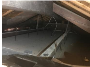
天井裏の無断熱を確認
