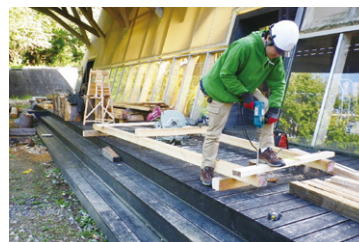
ウッドデッキを型紙に使い、採材、組み立てをしていきます。工具は、電動ドリル、丸鋸、一部にチェーンソーを使用しました。後ろに見えるのは、1/3スケールの模型。
