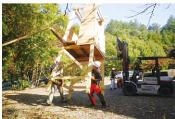
組み立てが終わったところで、設置場所に移動し、建て起こします。この時ばかりは、人手が必要。屋根や梯子は、後からボルトで取り付けます。
