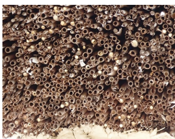
写真4 「虫の家」となっていた茅葺き屋根 虫が利用している茅は末端が白く詰まって見える
