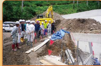
治山工事見学
