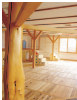
写真4 のり付けしない暖かい天乾杉の置き床・ペレットの床暖房
