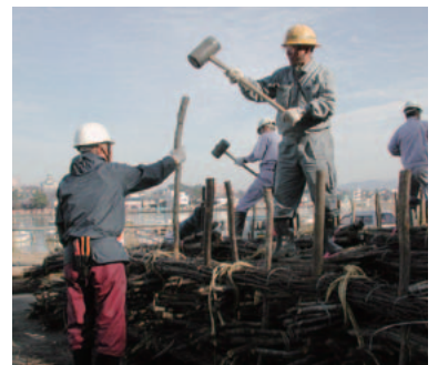
▲組み上げている途中の粗朶沈床 大量の粗朶が必要とされる
