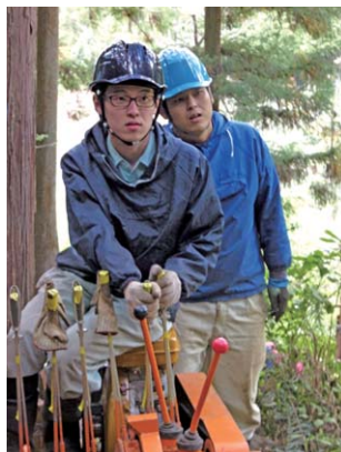
▲写真1 架線実習
