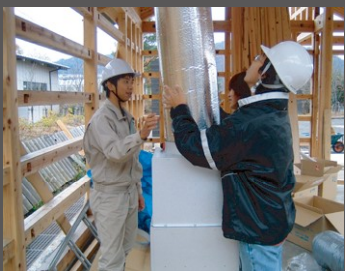
2003.12.01 ハンドリングBOX設置
