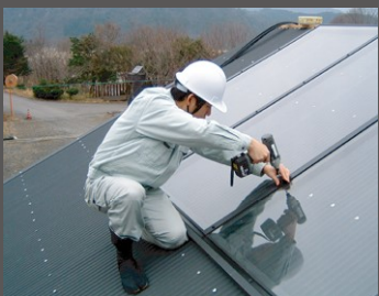
2004.03.26 集熱ガラス取り付け
