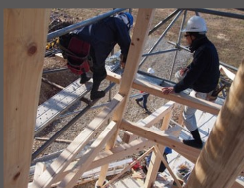
建方：足場での作業
