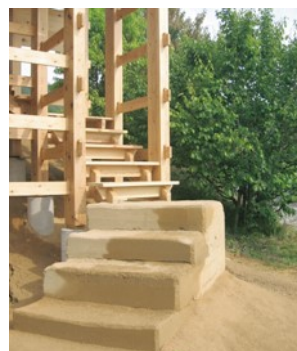
木製階段と版築階段
