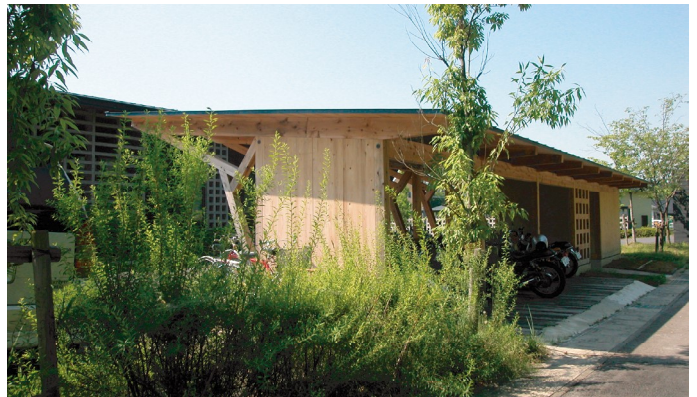
北東より見る
