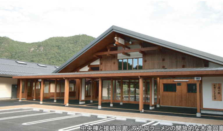
中央棟と接続回廊：双方向ラーメンの開放的な木造回廊
