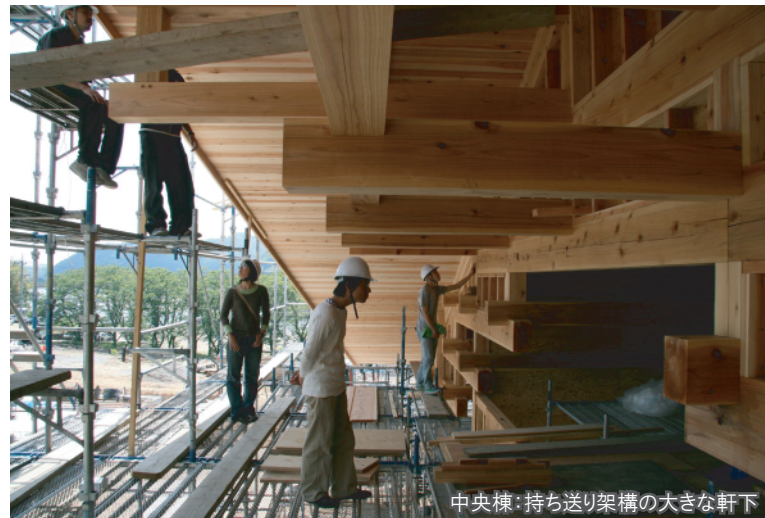
中央棟：持ち送り架構の大きな軒下
