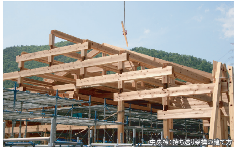
中央棟：持ち送り架構の建て方
