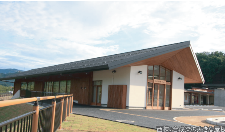
西棟：合成梁の大きな屋根
